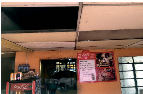
Interior del local
